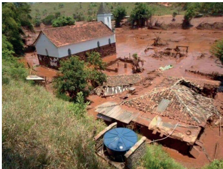
■ Vista da comunidade de Gesteira após rompimento da barragem de rejeitos de Fundão, em novembro de 2015.
