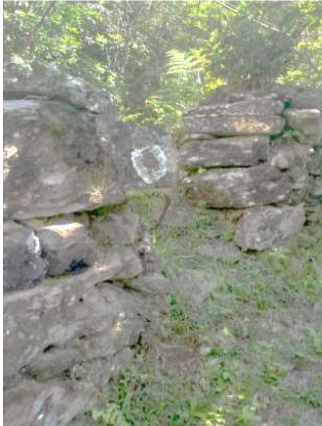
Imagem 25 - Ruínas de antiga Edificação com paredes pétreas indicada pelos moradores locais como “senzala”. Tripuí, Ouro Preto. Foto: M. Dionízio, dez. de 2024.
