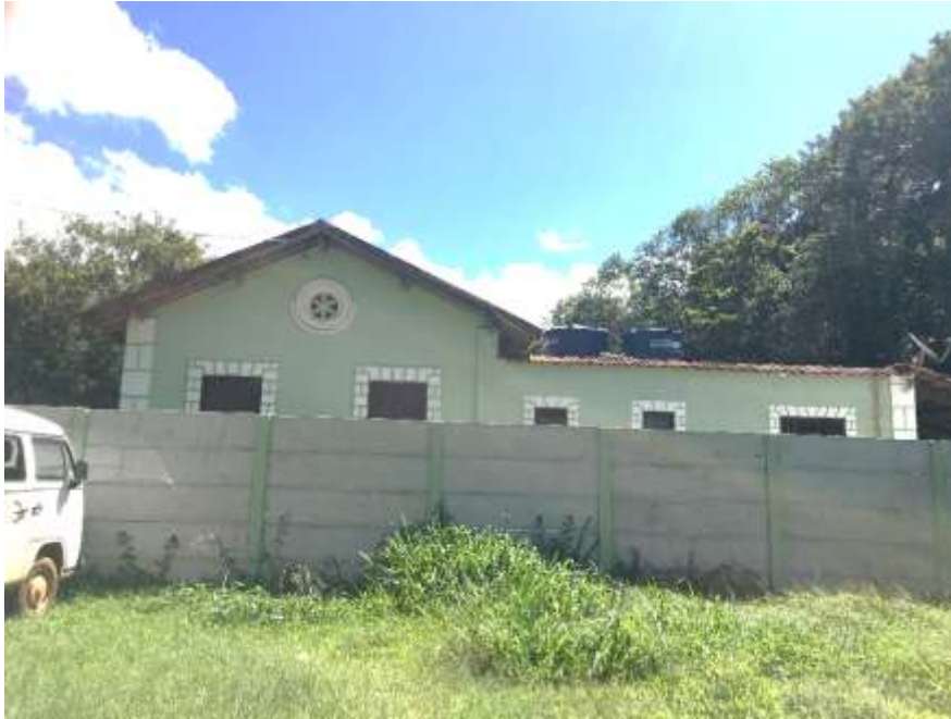
Imagem 11 - Casa que faz parte do conjunto histórico da Estação Ferroviária Tripuí, Ouro Preto, MG. Foto: A. Baeta, dez. de 2024.
