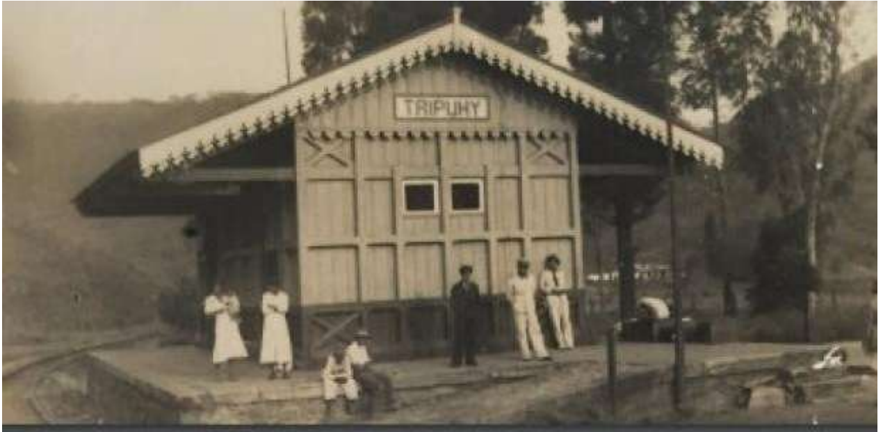
Imagem 7 - Prédio da Estação Ferroviária Tripuí datado de 1891. Fonte: ALVES, Agenor "O Menino do Tripuí", Ed. Liberdade, Ouro Preto, 2017.
