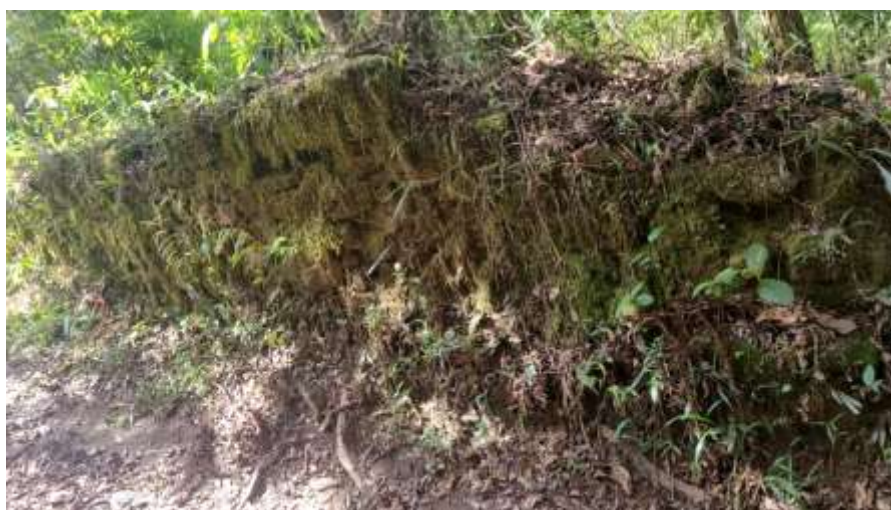
Imagem 16 - Muro de Pedra associado ao Caminho Calçado com seixos rolados em Tripuí, Ouro Preto. Foto: M. Dionízia, dez. de 2024.
