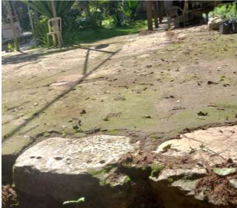
Imagem 21 - Alicerce de pedra de antiga casa de Pau a Pique. Tripuí, Ouro Preto. Foto: M. Dionízia, dez. de 2024.
