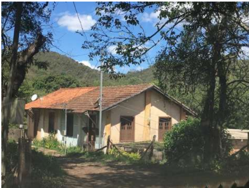
Imagem 10 - Casa que faz parte do conjunto histórico da Estação Ferroviária Tripuí, Ouro Preto, MG. Foto: A. Baeta, dez. de 2024.
