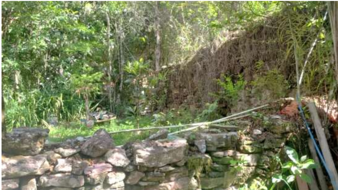
Imagem 24 - Ruínas de antiga Edificação com paredes pétreas indicada pelos moradores locais como “senzala”. Tripuí, Ouro Preto. Foto: M. Dionízio, dez. de 2024.
