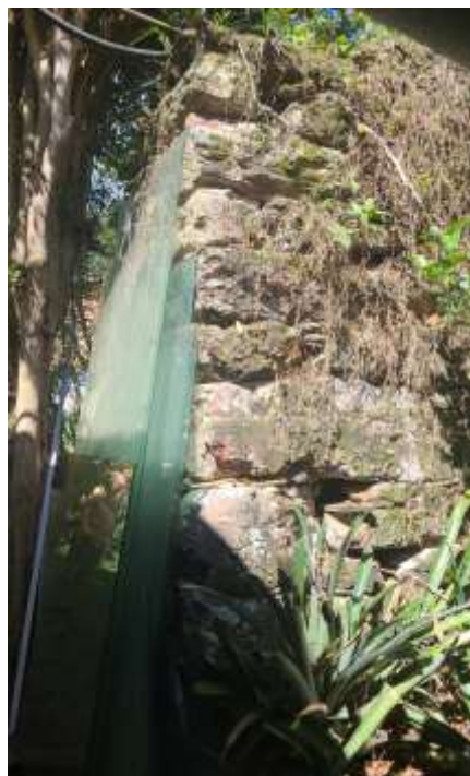
Imagem 26 - Ruínas de antiga Edificação com paredes pétreas indicada pelos moradores locais como “senzala”. Tripuí, Ouro Preto. Foto: M. Dionízio, dez. de 2024.
