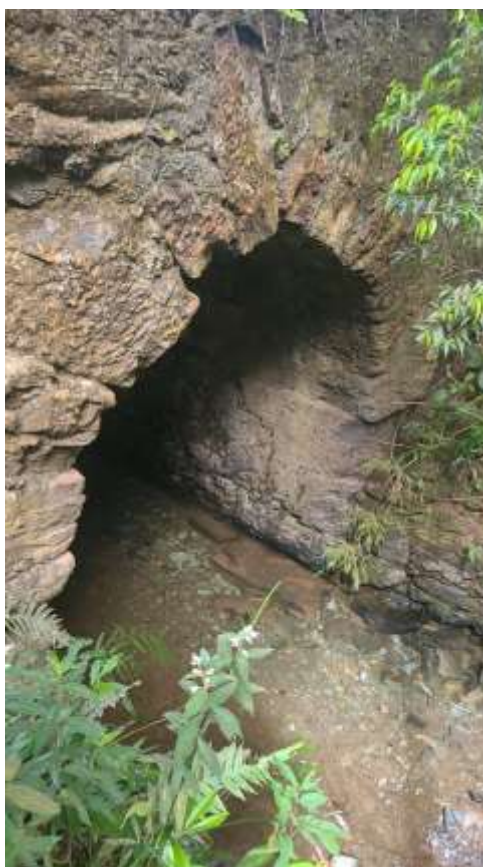
Imagem 18 - Ponte com arco de alvenaria de pedra que faz parte do sistema caminho calçado. Tripuí, Ouro Preto. Foto: M. Dionízia, dez. de 2024.
