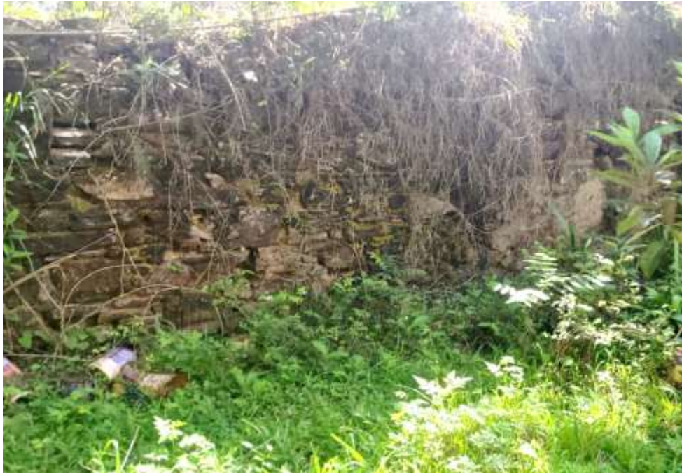
Imagem 27 - Ruínas de antiga Edificação com paredes pétreas indicada pelos moradores locais como “senzala”. Tripuí, Ouro Preto. Foto: M. Dionízio, Dez. de 2024.
