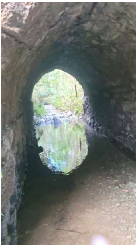
Imagem 17 - Ponte com arco de alvenaria de pedra que faz parte do sistema caminho calçado em Tripuí e regos de águas, Ouro Preto. Foto: M. Dionízia, dez. de 2024.
