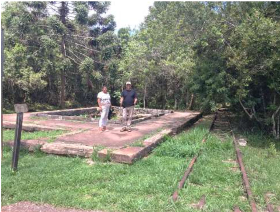
Imagem 8 - Base da antiga Estação Ferroviária Tripuí e trilhos remanescentes do século XIX. Ouro Preto, MG. Foto: A. Baeta, dez. de 2024.
