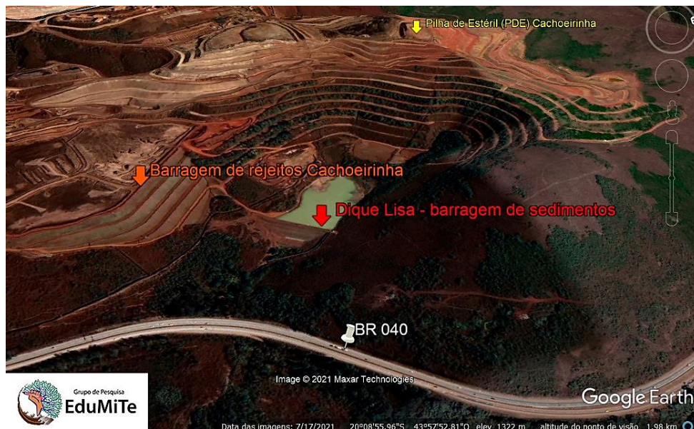
Complexo Mina Pau Branco – Vallourec. Barragem de rejeitos, sedimentos e Pilha de Estéril. Fonte: grupo de pesquisa Educação Mineração e Território – Edumite.
